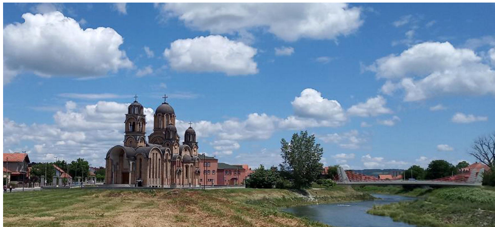
Слика 3. – Црква и мост у Котлујевцу
